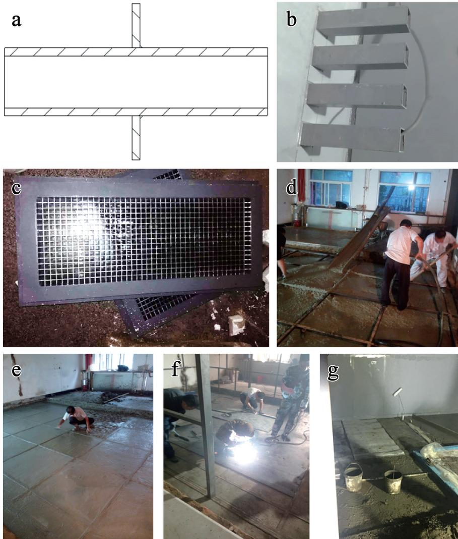
图 4 a. 截止波导孔示意图;b. 为安装完成后的一侧图;c. 截止波导窗;d-f. 地面施工;g. 地面混凝土施工内骨架材料。
