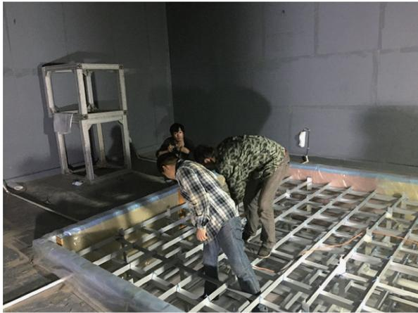
图 7 被动减震台内的角铝型材替代钢筋。
