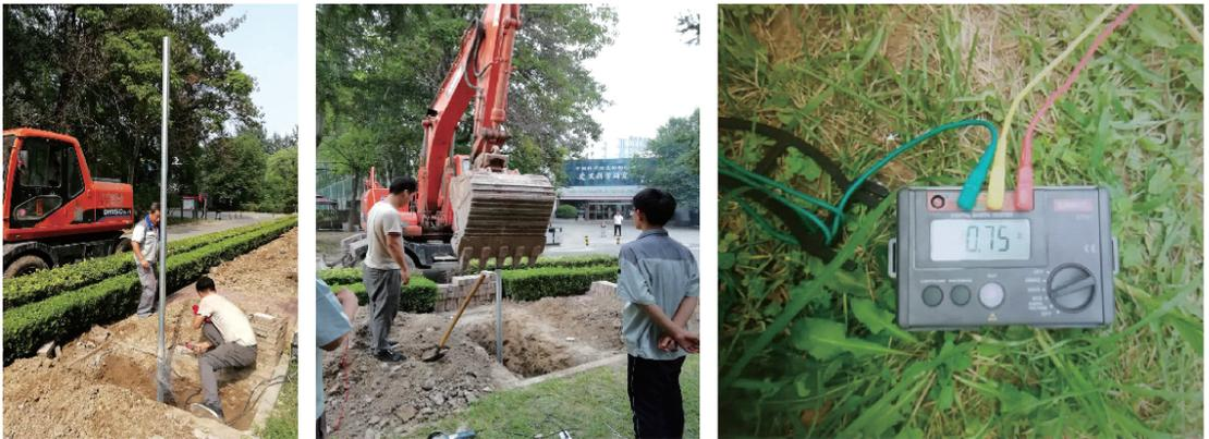
图9 独立地线现场施工图。
