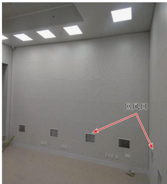
图5 电镜室内两面墙上回风口。
